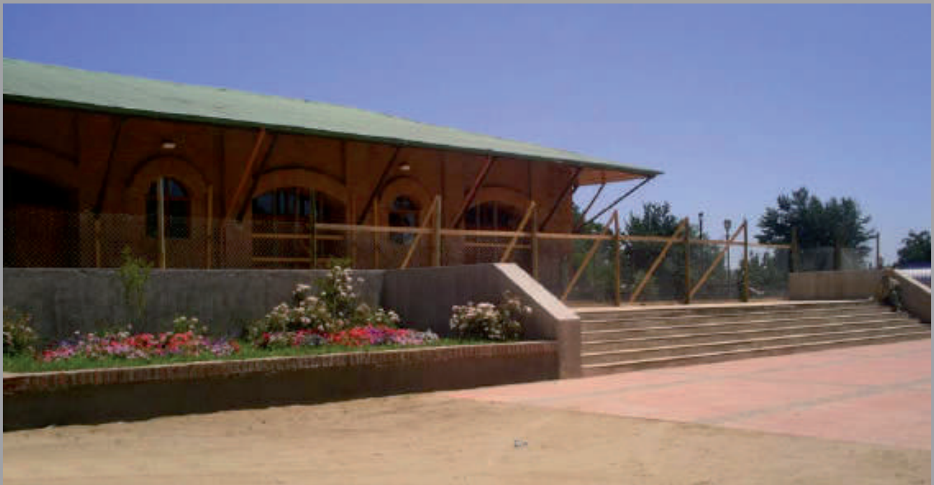
Estación de Trenes
